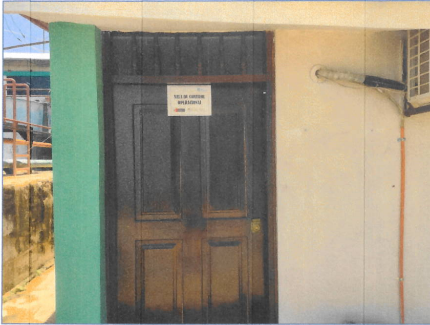
Sala de Control Operacional, ubicada en las instalaciones de la Sede Central de EMAPA SAN MARTÍN.
